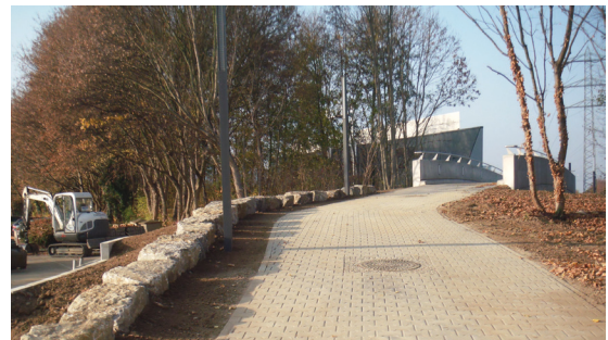
SEW Saalbachbrücke, Bruchsal
